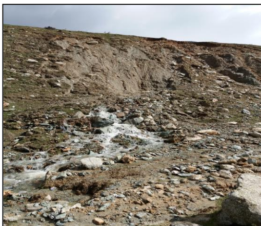
Εικόνα 8. Διαρροές στο πόδα του κατάντη πρανούς.
