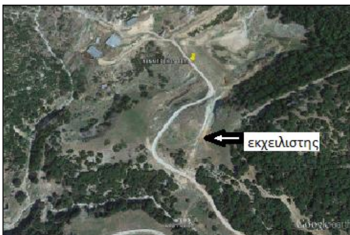
Εικόνα 3. Ο υπερχειλιστής του φράγματος.
