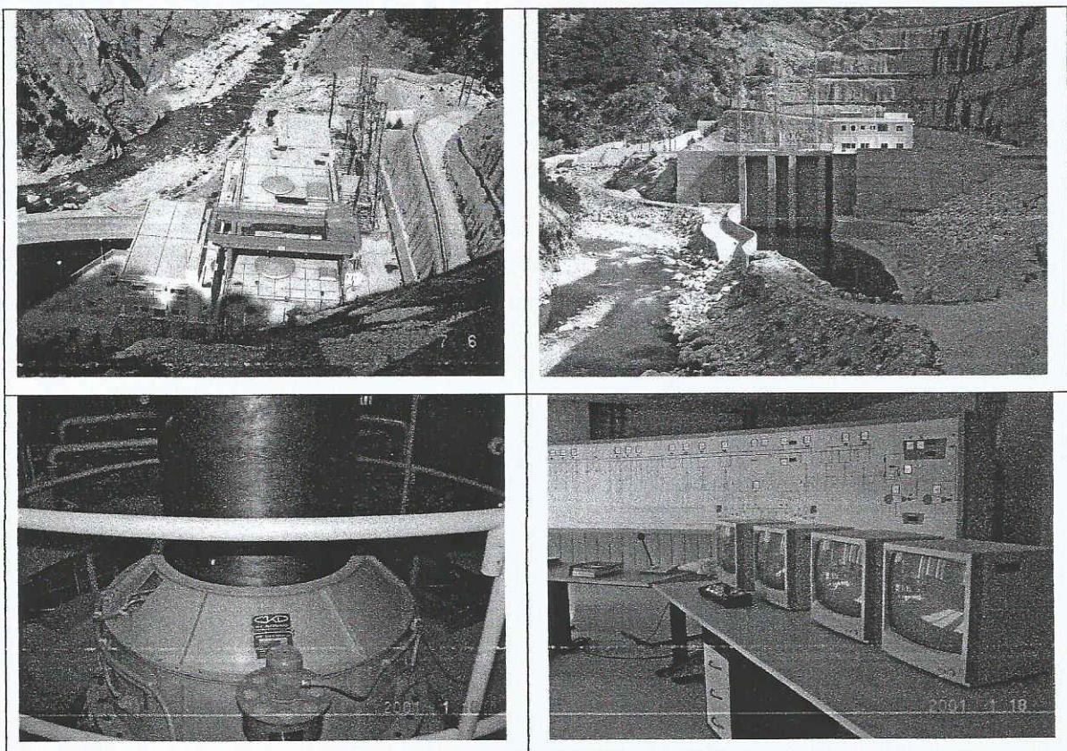
Ο Ηλετρομηχανολογικός Εξοπλισμός περιλαμβάνει Προμήθεια και Εγκατάσταση Στροβίλων  $D=2800\text{MM}$ , Ριθμιστών Στροφών, Σφαιρικών Βαλβίδων  $D=2300\text{MM}$ , Γεννητριών, Μετασχηματιστών, Θυροφραγμάτων Λειτουργίας – Εκχειλιστή – Υδροληψίας και Δοκών Εμφραξης.
