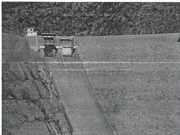
Η συνολική κατασκευή που βρίσκεται στο Δεξιό Αντέρεισμα ανήλθε σε **52.000 m<sup>3</sup>** σκυροδέματος και εξασφαλίζει μέγιστη εκροή **3.300 m<sup>3</sup>/sec.** Η μεγάλη κλίση και το μήκος της Κεκλιμένης Διώρυγας (47%) επέβαλαν την κατασκευή τριών Αεριστών εκατέρωθεν αυτής.
