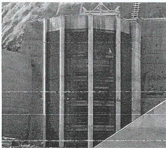
Βρίσκεται στο Αριστερό Αντέρεισμα είναι κατακορύφου τύπου με Φρέαρ Θυροφραγμάτων ύψους **55 m**, διαμέτρου **5,30 m** με διαστάσεις ανοίγματος στην θέση των Δοκών Εμφραξης **7,39 x 4,20 m** και στάθμη δαπέδου στο υψόμετρο **716,00**.
