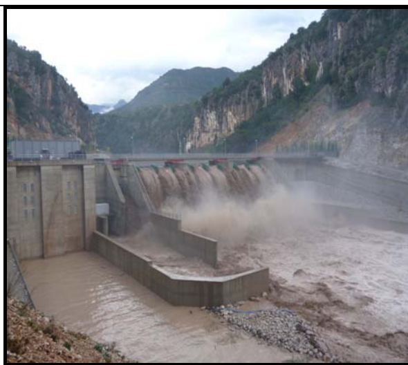
Εικόνα 2: Μικρό Υδροηλεκτρικό Έργο Δαφνοζωνάρας στον ποταμό Αχελώο
