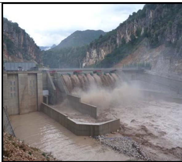
Εικόνα 2: Μικρό Υδροηλεκτρικό Έργο Δαφνοζωνάρας στον ποταμό Αχελώο
